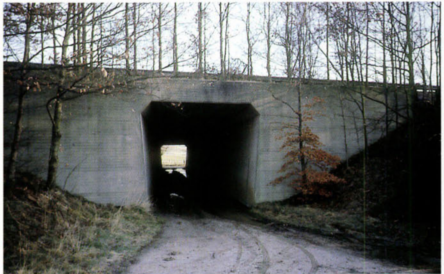
FIGUUR 13 Hoe ruimer de faunapassage, hoe meer zoogdiersoorten er gebruik van kunnen maken. Dit bestaande viaduct onder de A76 (3,6 meter hoog en 4 meter breed) wordt door 16 zoogdiersoorten gebruikt, zoals Egel, Steenmarter, Das en Ree (dia: S. Jansen).
