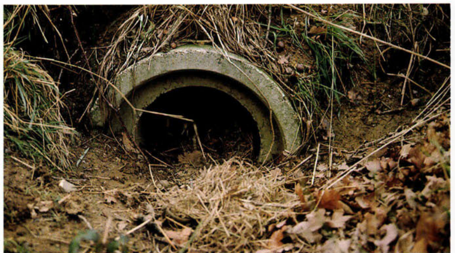
FIGUUR 15 Dassentunnels die regelmatig door Dassen worden benut, voldoen niet aan de eisen voor andere zoogdiersoorten. Hier bijvoorbeeld een dassentunnel die door een Das volgepropt is met nestmateriaal en dienst doet als kraamburcht. Voor alle duidelijkheid: de Das zelf is niet het probleem. Het grootste probleem wordt veroorzaakt door de geringe afmetingen van dit soort faunapassages (dia: S. Jansen).
